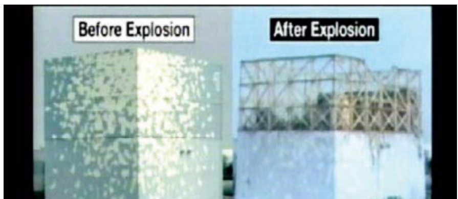
La centrale nucleare di Fukushima prima e dopo l'esplosione
